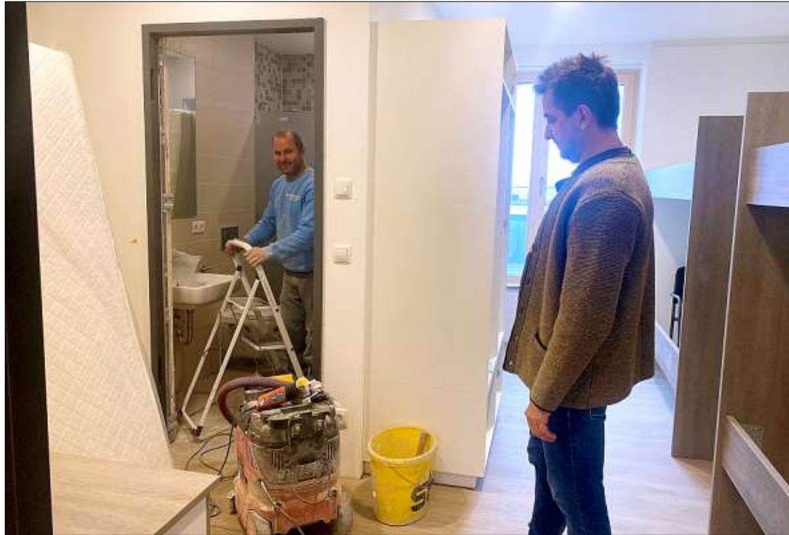
Auf der Baustelle im neuen Trakt geht es gut voran: In der neuen Unterkunft im früheren Feuerwehrhaus freut sich Roland Pongratz (r.), dass Handwerker Matthias in der Nasszelle fast fertig ist. Die Möbel – hier die Stockbetten (rechts) – sind auch teilweise schon aufgebaut. – Foto: Löw
