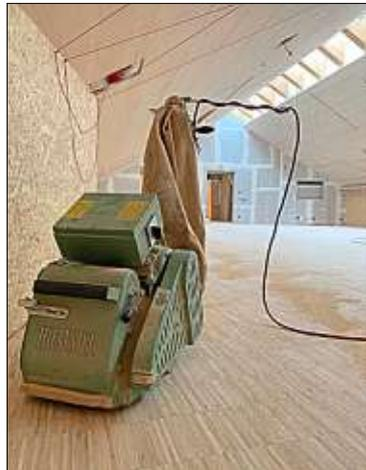
**Im Dachboden** der Akademie wurde bereits der Schwingboden für die Tänzer eingebaut und abgeschliffen. – Foto: Tomys
