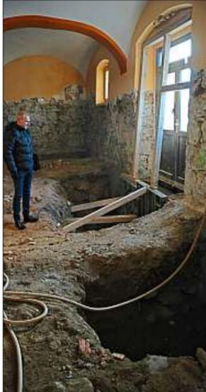
**Stück für Stück** wird derzeit unter das alte Fundament Beton gegeben, damit die späteren Lasten getragen werden können.
